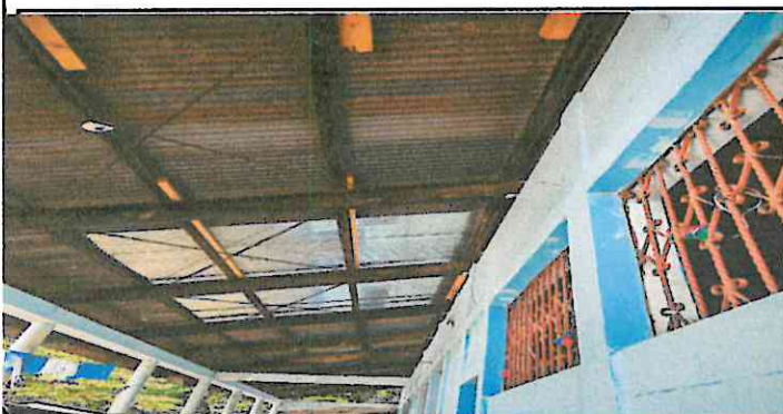
5. bigas de madera en mal estado e incluso con polilla
